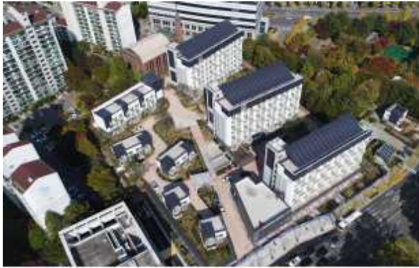
※건축물일체형 태양광 전지판
