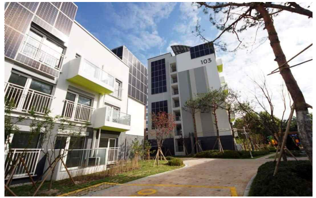
※건축물일체형 태양광 전지판
