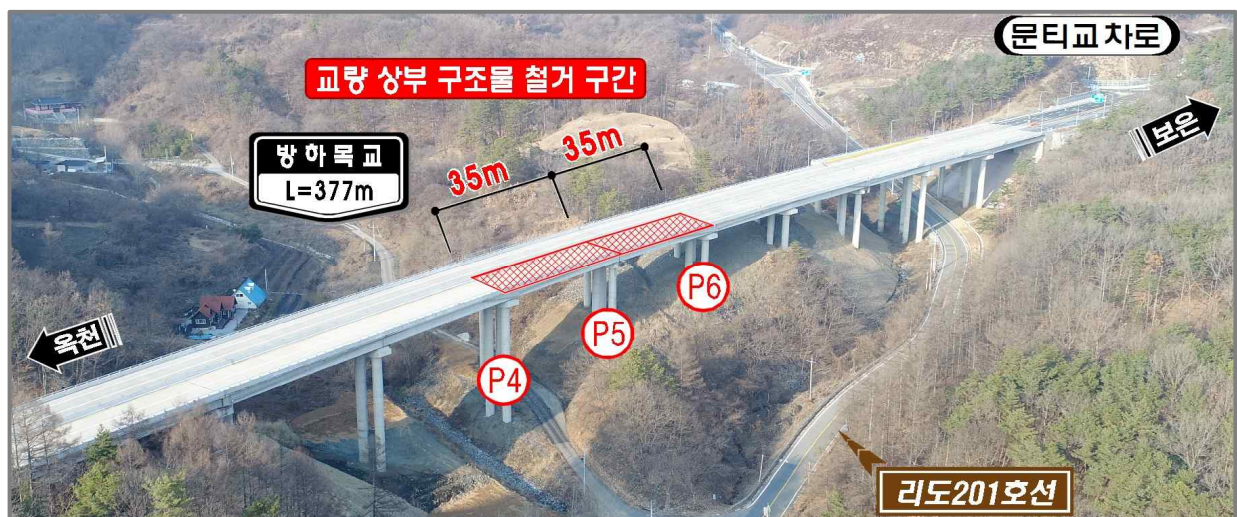
< 방하목교 상부 구조물 철거(재시공) 구간 >
