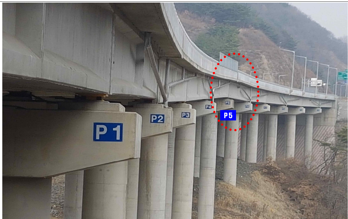
교량 측면 전경
