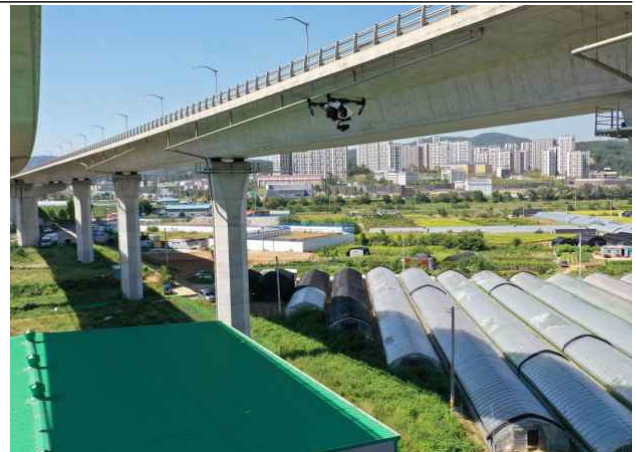
드론 활용 교량 점검
