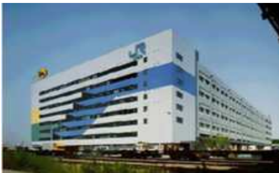
[ 도쿄 화물터미널역 내 종합물류시설 ]
