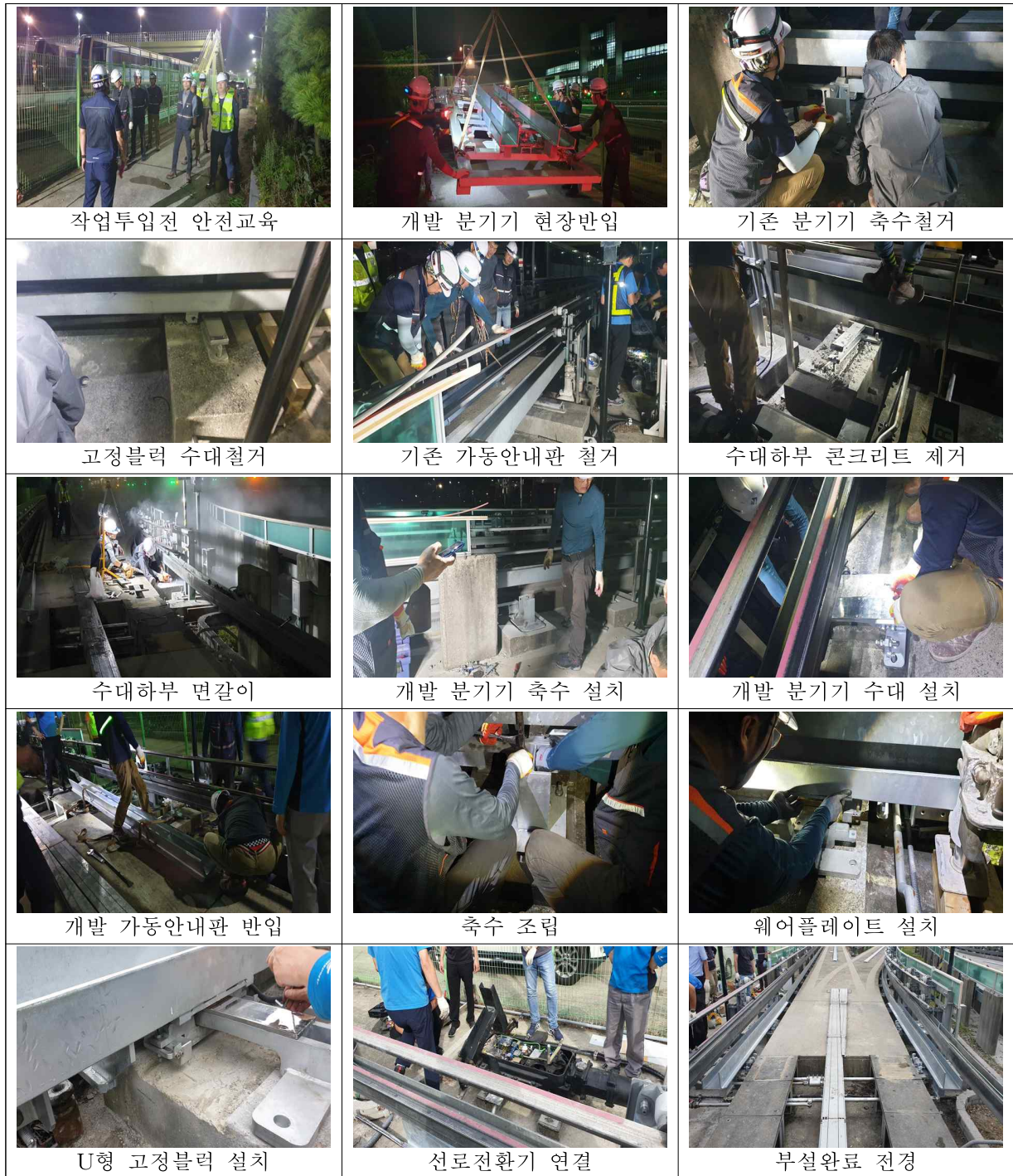
<그림 1> 수평안내식 고무차륜 AGT 분기기 교체 시공공정
