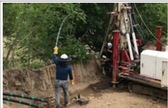
② 주입관(멘젯튜브) 설치
