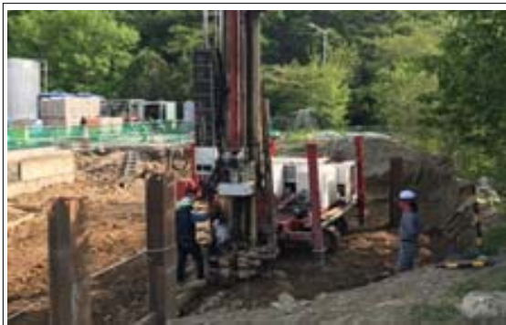
① 천공 및 케이싱 설치
