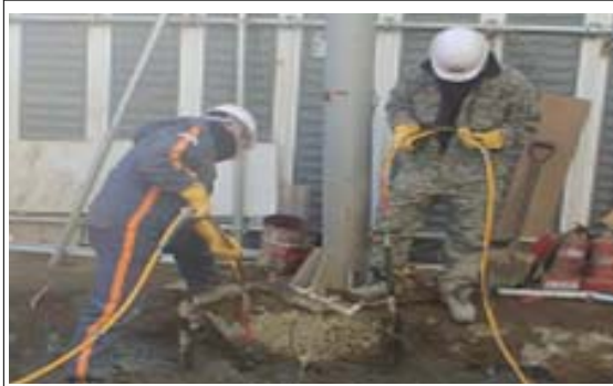
⑤ 멘젯튜브 내 팩커 설치
