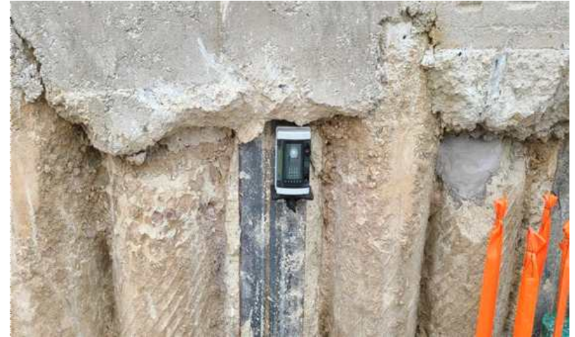
개선 후 위험지역 위험알리미 설치 사용
