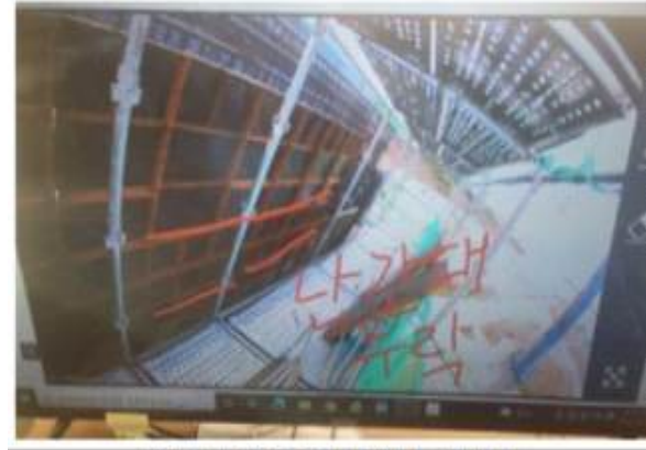
거꾸집 완료후 난간대 재설치 (포항-안동2-2(공구))
