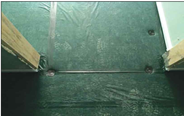
<완충재 연속시공 등 현장 시공관리>
