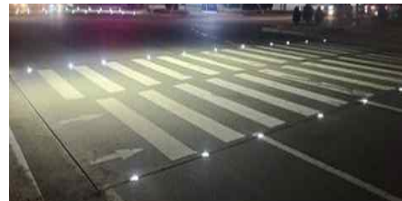
< 횡단보도 표지병 설치사례 >
