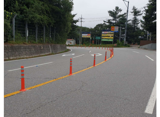
▲ 시선유도봉 등 도로안전시설 설치 우수
