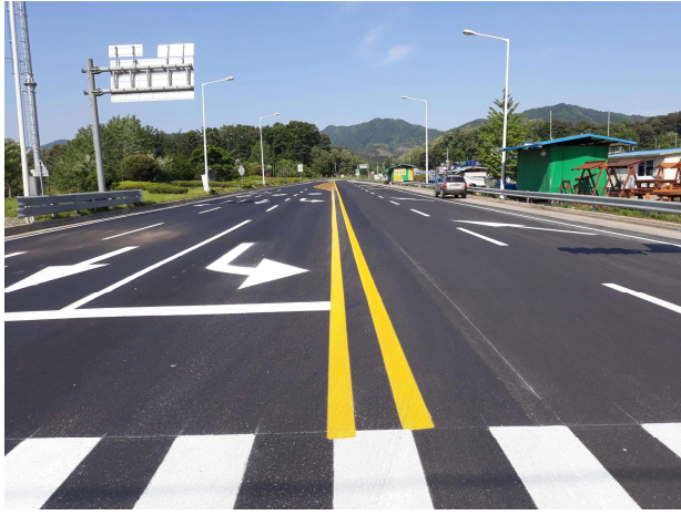
▲ 도로포장 및 차선도색 정비 우수
