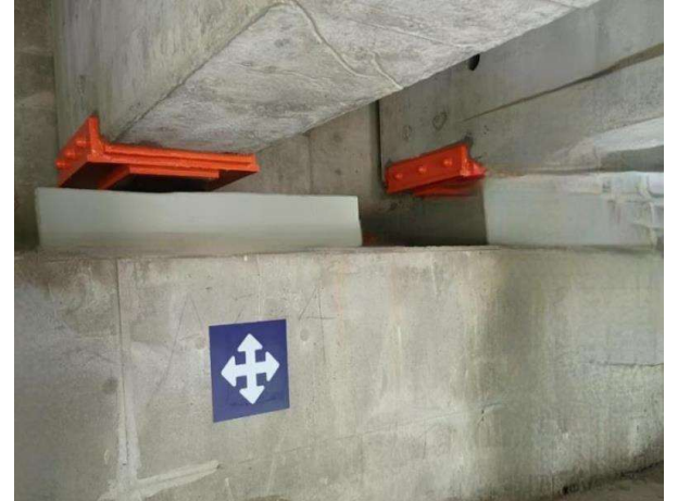
▲ 교량받침 등 교량관리 우수
