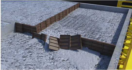
③ 바닥 타설 중 고정하중이 증가하며 바닥 중앙부로 쏠림현상 발생
