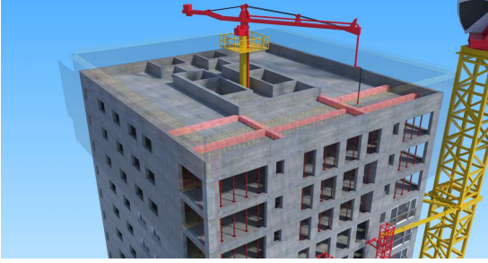
① 39층 바닥 슬래브 타설을 위한 가벽 설치(구조안전검토 미실시)
