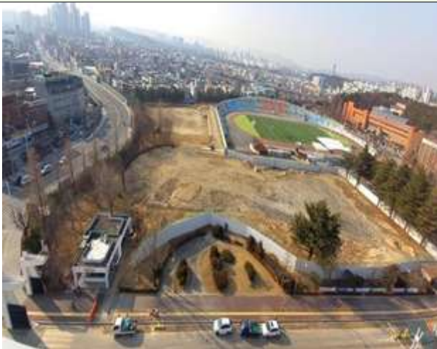
도시첨단산업단지 조성 공사 현장
