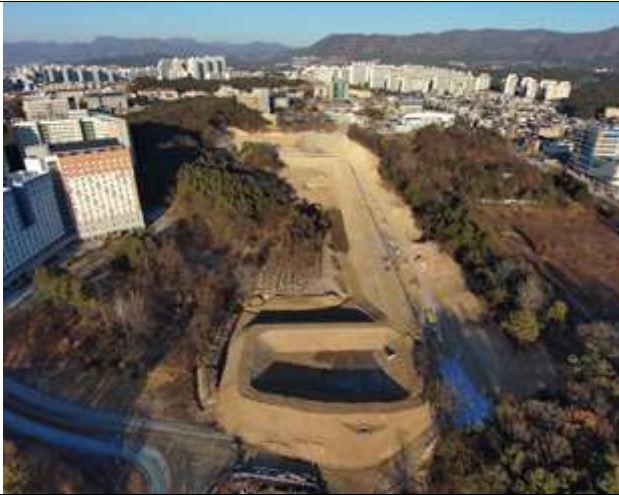
도시첨단산업단지 조성 공사 현장
