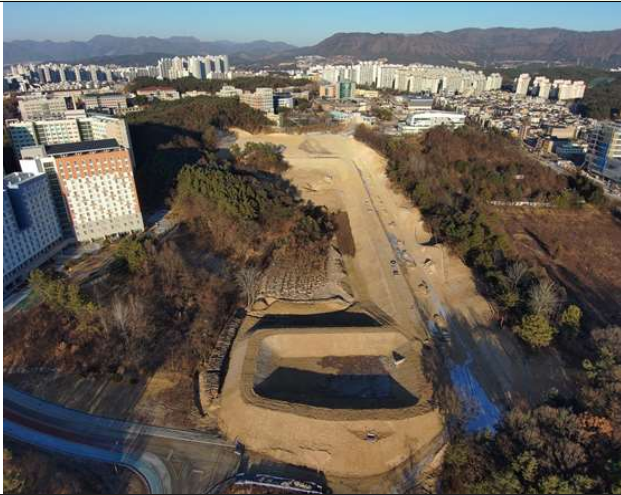
도시첨단산업단지 조성 공사 현장
