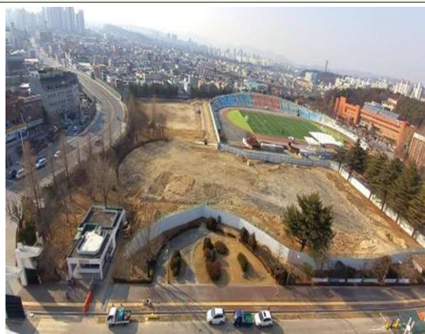
도시첨단산업단지 조성 공사 현장
