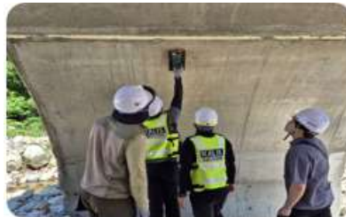
합동안전점검 사례 (설악산 교량)
