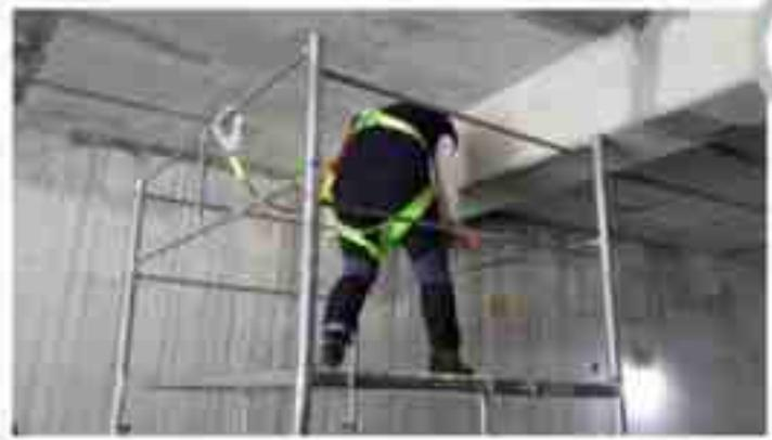
상부·중간 난간대 설치 및 설치높이(90~120) 준수
