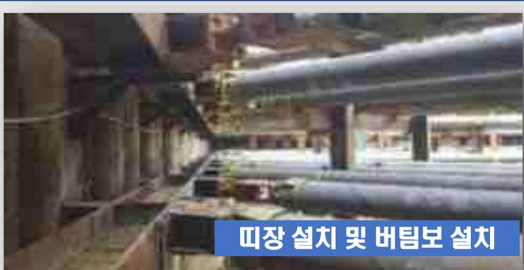
띠장 설치 및 버팀보 설치
