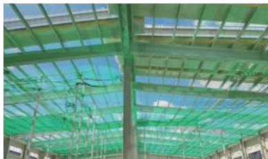
골조 하부 추락방지망 설치(예시)
