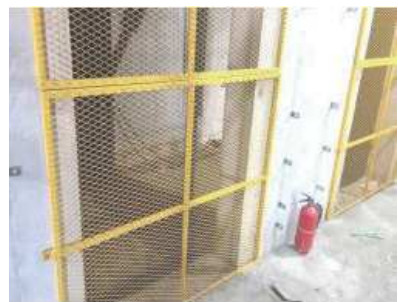
엘리베이터 개구부 안전난간 설치(예시)
