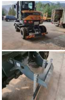
작업발판 등 안전시설 설치
