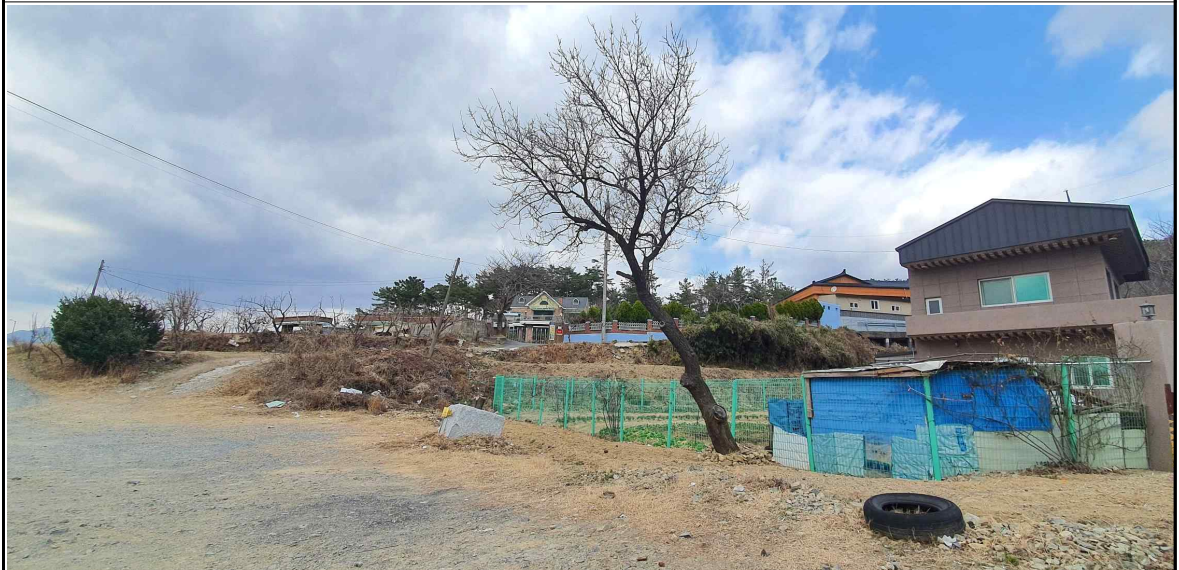
⑦ 계획지구 내 지장물(단독주택)
