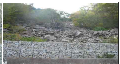
돌망태 옹벽 설치
