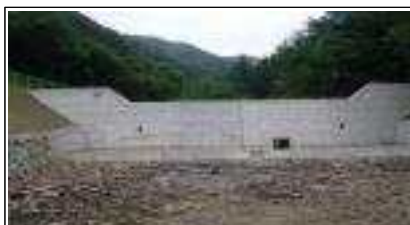
콘크리트 사방시설 설치
