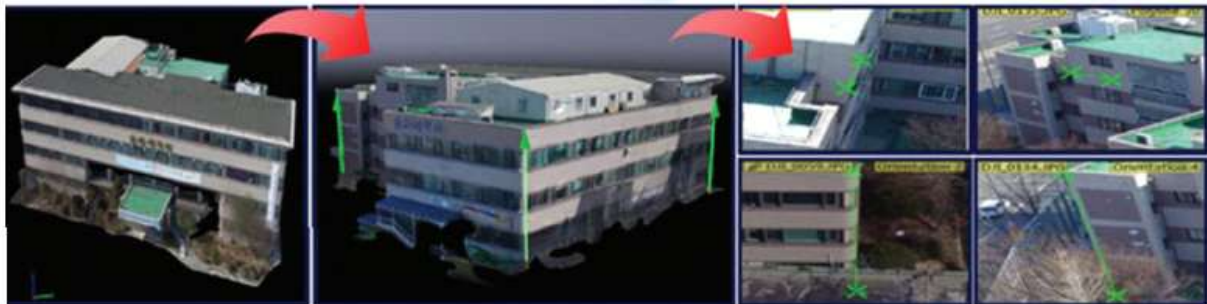
[건축물 안전진단(모델링 및 보정작업(왼쪽, 가운데), 건물 기울기 및 각종 균열 측정(오른쪽))]
