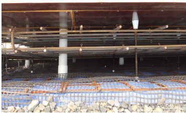
j. 철근 배근/거푸집 설치
