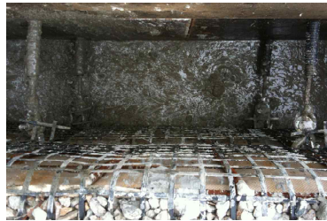
k. 벽체 콘크리트타설
