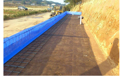
c. 기준틀 및 보강재 설치
