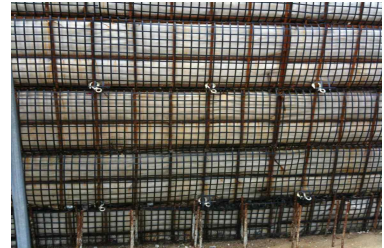
i. 연결재 설치
