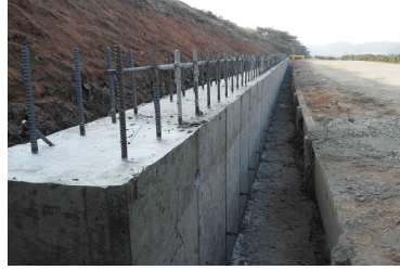
b. 벽체 기초 설치
