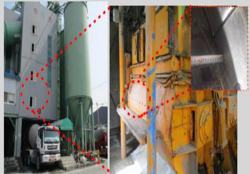
〈믹서 위치 및 믹서내부 전경〉
