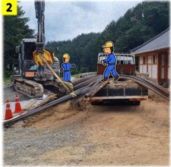
건설장비(굴삭기)를 활용하여, 철근 다발을 트럭에 상차 작업중
