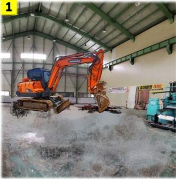
1 공장 내 신규 설비 설치를 위해 터파기 작업 중
