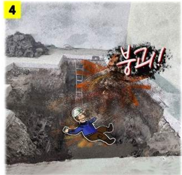
4 작업자 1인 대기 중, 터파기 굴착면 붕괴되어 매몰 사망
