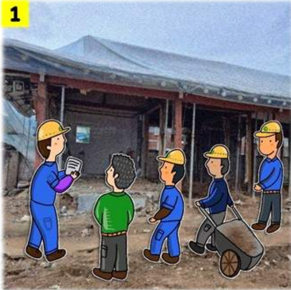
1 단독주택 리모델링 공사 중 (50년이 넘는 노후화된 주택)
