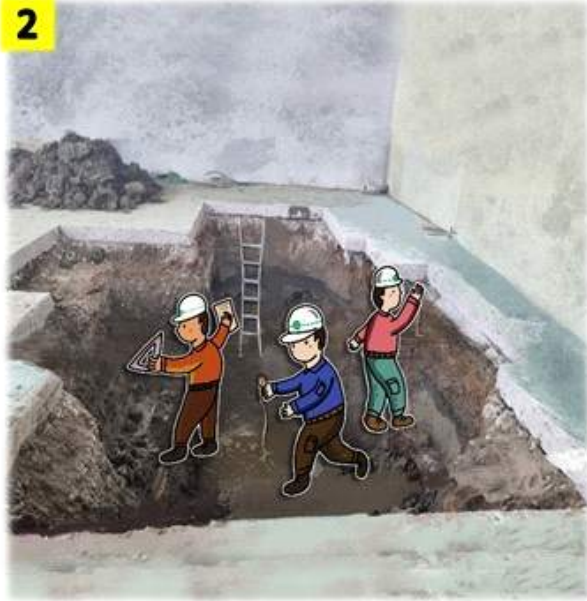
2 작업자 3인 굴착 깊이가 확인 측량 후
