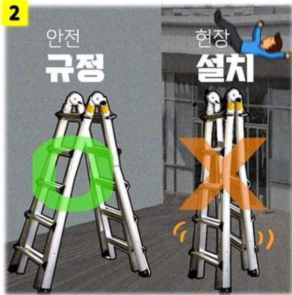
편의를 위하여 A형 사다리를 일자로 설치
