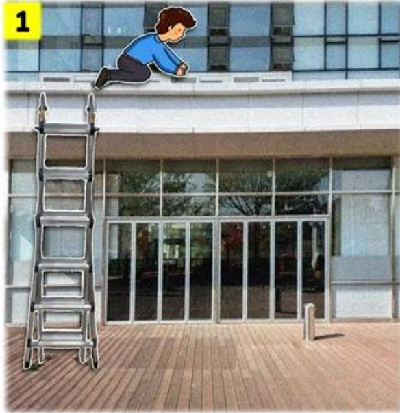
2층 외벽 보수 작업 중
