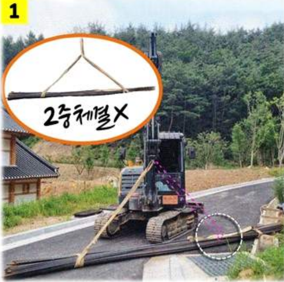
상주시 일원 관광시설 건축공사중, 도로변에 적치된 철근을 공사현장으로 운반
