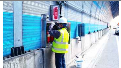
<방음터널 방재시설 보강>
