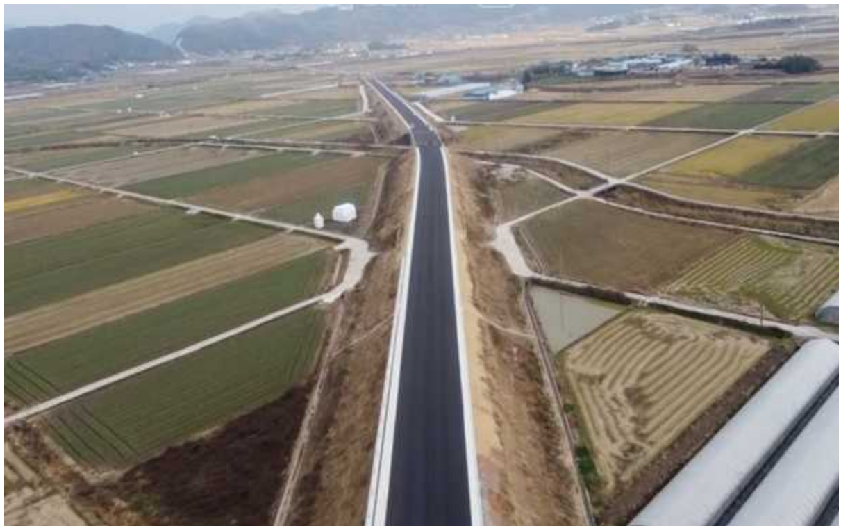
신설노선 전경(B=11.5m, 2차로)
