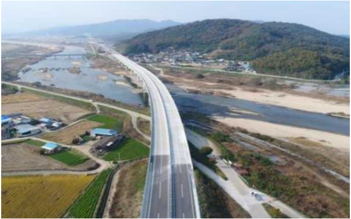
감천교 전경(S.T BOX 거더교, B=21.2m, L=753m)
