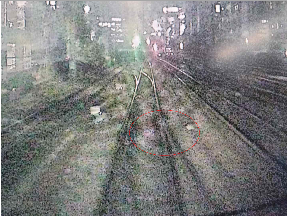
사고발생 4분전 운행한 선행열차(KTX)의 사고지점 통과전 전방 CCTV 영상 캡처 사진(레일 절손 파단면 식별 되지 않음)
