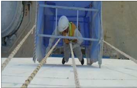
(C) 건물 외벽 도장 시 방진망
