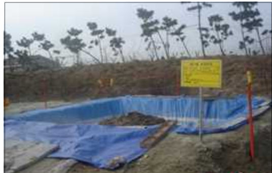
(B) 건설 퇴적토 적재
