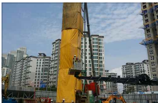
<그림 7> 항타 또는 보링시 방음·방진커버 설치
