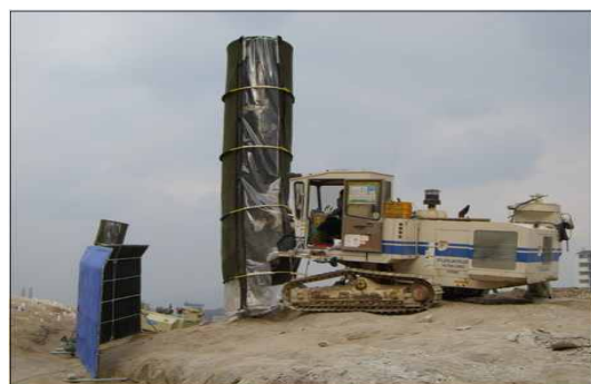
<그림 7> 항타 또는 보링시 방음·방진커버 설치
