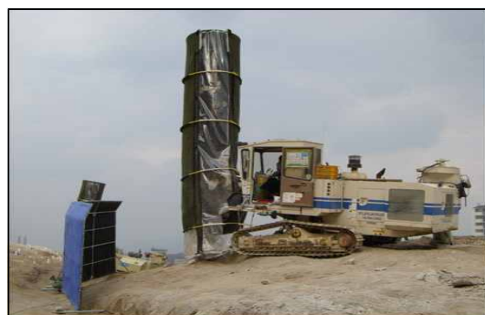
<그림 7> 항타 또는 보링시 방음·방진커버 설치
