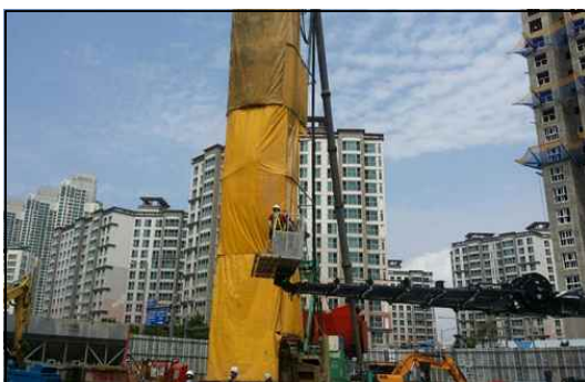
<그림 7> 항타 또는 보링시 방음·방진커버 설치
