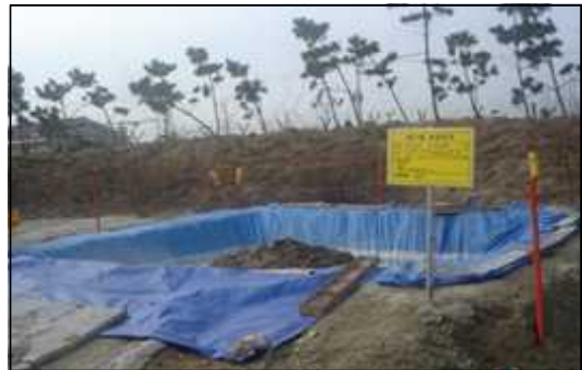
(B) 건설 퇴적토 적재
