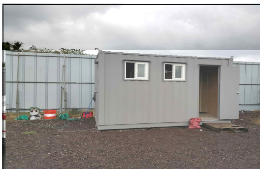
(A) 공사장 이동식 화장실
