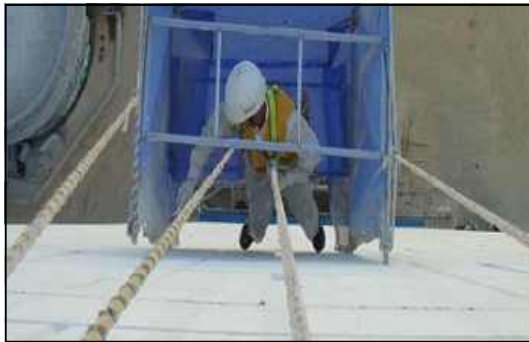
(C) 건물 외벽 도장 시 방진망
